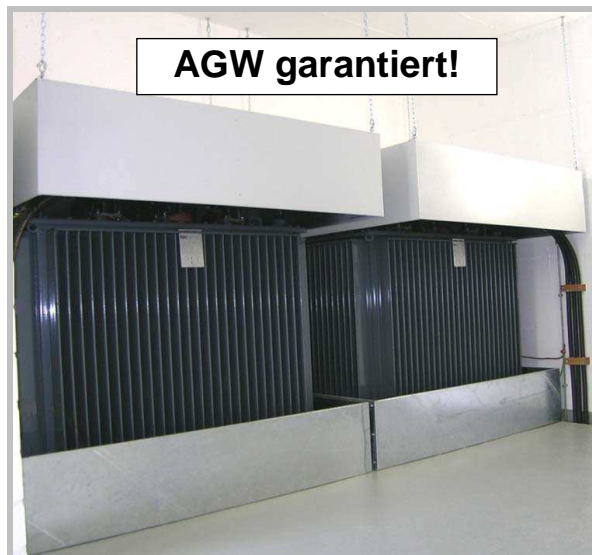
Kompakt-Abschirmungen auf 630kVA Trafos
