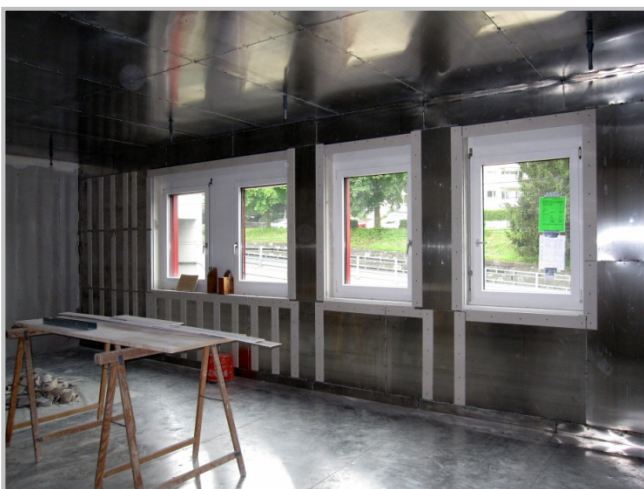
Bild 3: Raum fertig geschirmt. Abschirmplatten werden mit Gipskartonplatten abgedeckt
